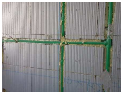
Tracce su isolamento interno
