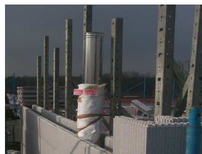
Passaggio all'interno della parete
