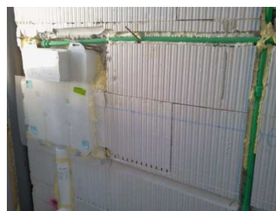
Cassetta inserita parzialmente nella parete previa scanalatura
