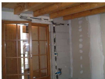
Tracce impianto elettrico
