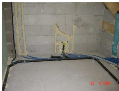
Chiusura tracce con schiuma poliuretanic
